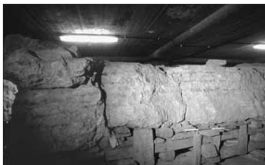
Fig. 7 Spezzone crollato di un segmento di volta di copertura del primo ordine della basilica Ulpia
